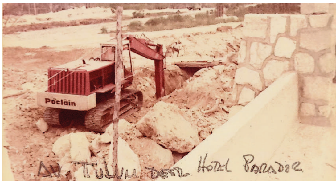
Esta gráfica, captada desde la obra negra del hotel Parador, muestra con claridad que avenida Tulum seguía siendo una vía sin pavimentar a fines de 1973. (Jorge Ávila Mariño)
