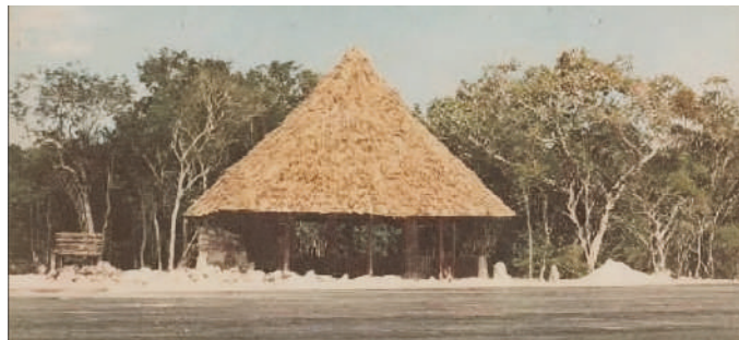
Las imágenes más antiguas que tenemos del primer aeropuerto, de noviembre de 1971. En la primera se aprecia la construcción de la palapa
