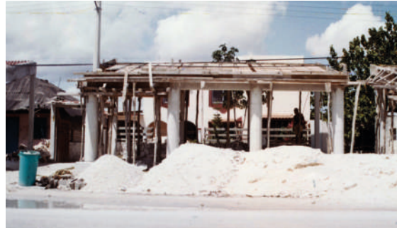
Imágenes de la construcción de la arcada de Puerto Juárez, un proyecto elaborado por el urbanista Enrique Flores.
